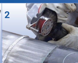
2 Preparo de superfície: Sa2½ / St3 & rugosidade Rz > 60 µm
